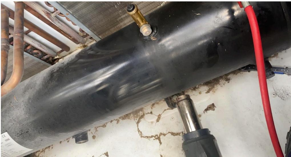
8) Ouverture du circuit pour effectuer le remplacement des pressostats HP sécu raccordés en direct sur le compresseur (amenant à un isolement du compresseur impossible), les câbler sur leurs bornes respectives (pour faciliter la tâche nous suivons le trajet des anciens pressostats vers leurs bornes) puis faire le remplacement des filtres déshydrateurs ainsi que des soupapes de sécurité.
