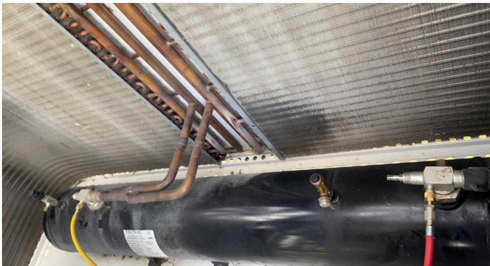
4) Isoler la vanne HP et BP du compresseur ainsi que la vanne du départ liquide + disjonction de tous les organes donc mise à l'arrêt de l'installation.
