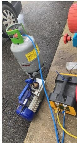
6) Récupération du fluide frigorigène restant dans le condenseur, le compresseur, la bouteille liquide ainsi que le reste de la tuyauterie jusqu'à l'obtention de 0 bar.
